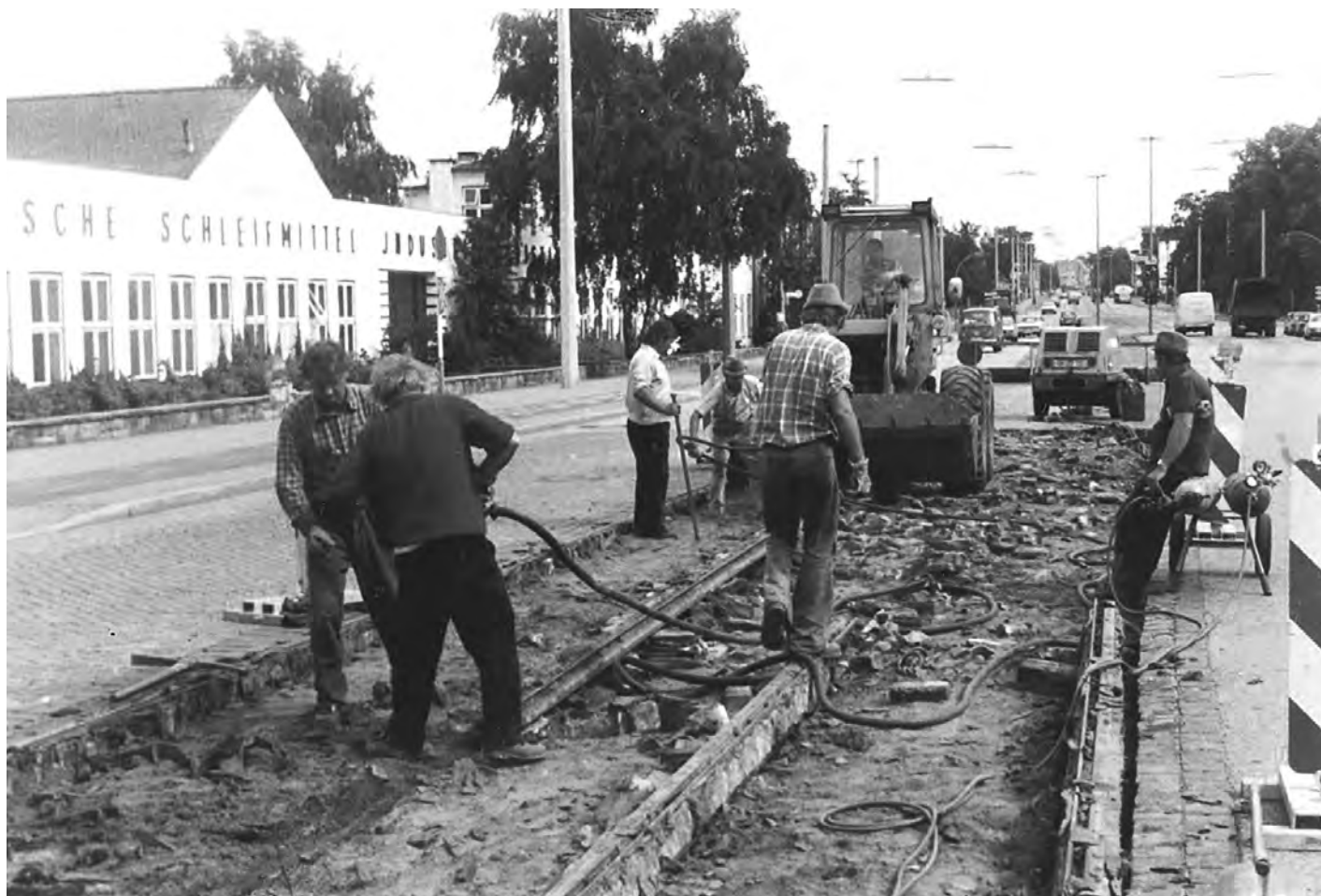
1976 - Demontage der Straßenbahnschienen in Lurup, Foto: Archiv Luruper Nachrichten, Frank A. Bastian
